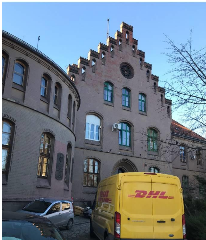
Zdj.1. Wejście główne do budynku
