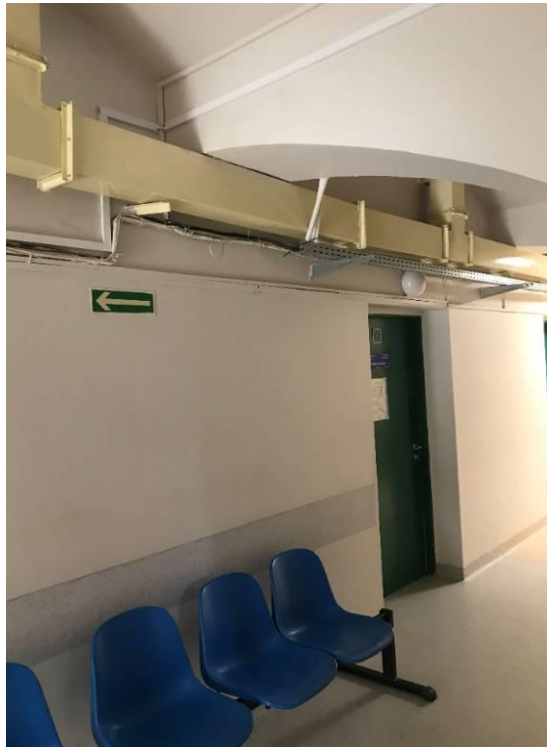
Zdj.1. Poradnia Kliniki Endokrynologii, Diabetologii i Leczenia Izotopami(remont)-korytarz
