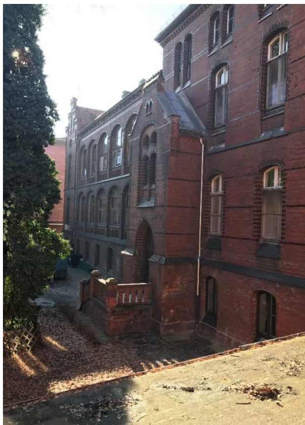
Zdj.3. Elewacja od strony dziedzińca-tę część zajmuje obecnie Oddział Endokrynologii.
